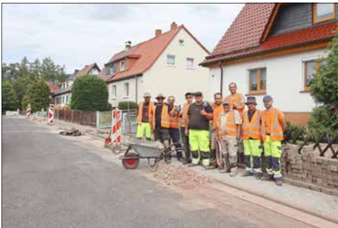
Gruppenbild des Teams bei der Glasfaserverlegung an der Friedensstraße.
