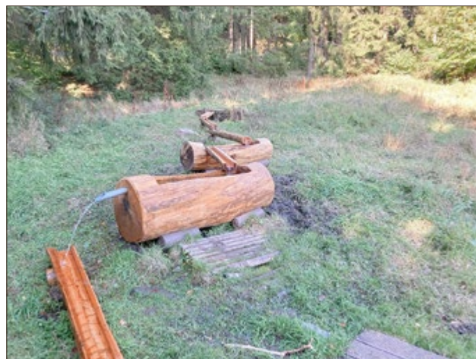
Andreas Happ hat die Tränkröge am Lämmerfleck erneuert.
