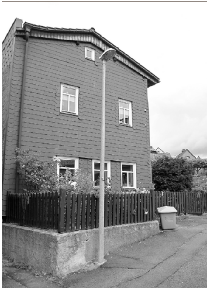
Hintergasse 7, Sanierung des Sockels und Erneuerung des Holzzaunes
