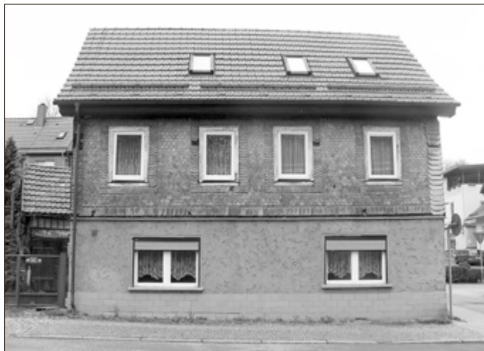
Oberhofer Straße 14, Sanierung der Fassade und der Gaupen, Erneuerung der Fenster
