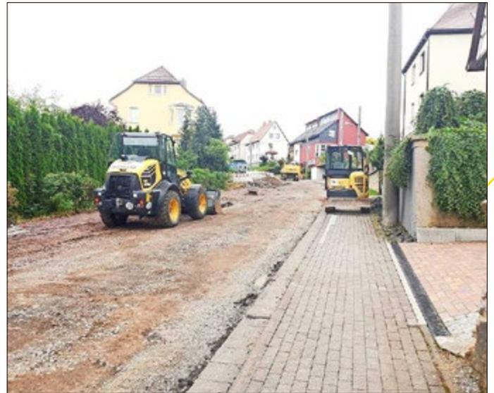
Dadurch wird die Installation einer neuen Straßenbeleuchtung erforderlich. Diese und die grundlegende Erneuerung der Verkehrsanlage sind innerhalb der Gemeinschaftsmaßnahme Aufgaben der Stadtverwaltung. Geplant ist die Verbreiterung der Fahrbahn auf durchgehend 6,50 Meter. Für die Bordanlagen werden Granitsteine verwendet. Die neue Straßenbeleuchtung (LED-Leuchten auf Stahlrohrmasten) soll wieder auf der rechten Straßenseite installiert werden.
