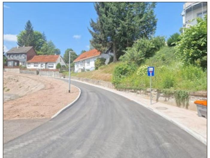
Die ursprüngliche Stützmauer war dabei Stück für Stück angeböschert worden. Sie war sehr marode, ein Neubau wäre viel teuer als die Böschung geworden. Im Zuge der Baumaßnahme, die durch die Straßen- und Asphaltbau Rennsteig GmbH durchgeführt wurde, wurde die Geigengasse komplett saniert und mit LED-Leuchten ausgestattet. Die Kabel zur Stromversorgung und für die Straßenbeleuchtung wurden dabei unterirdisch verlegt, zuvor waren noch Freileitungen gespannt.
