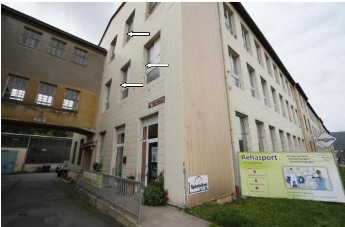
Abb. 3: Dämmfassade Gebäude 1 mit offenen Spalten
